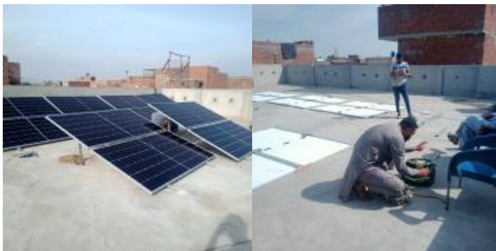
24 nieuwe zonnepanelen, de dakrand is verhoogd ter bescherming van de panelen
